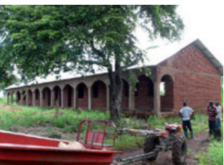
eine Schule wird gebaut
